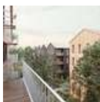
303 122 logements en bois Champs-sur-Marne
