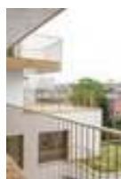
239 14 logements et une crèche Paris 20e
